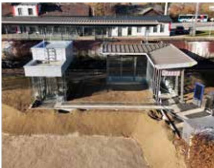
Bahnhof Althofen: Neuer Lift ermöglicht künftig barrierefreien Zugang zur Ostseite des Bahnhofs.
