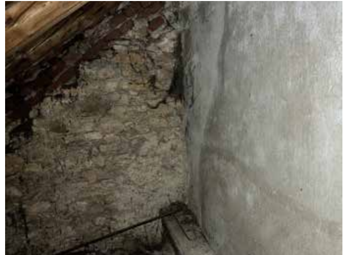
Der verputzte Altarraum mit umlaufendem Dachgesims und die unverputzte barocke Giebelmauer im Dachraum der Kirche (Quelle: Stadtarchiv Althofen)
