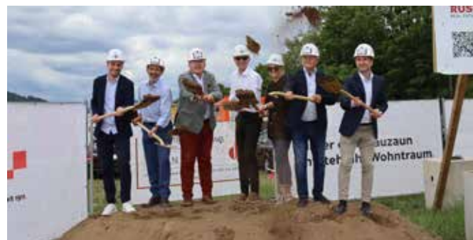
Spatenstich in Krumfelden: Mit dem Projekt „Green Living Althofen“ errichtet die gemeinnützige Wohnbaugenossenschaft erstmals Wohnungen in Kärnten.
